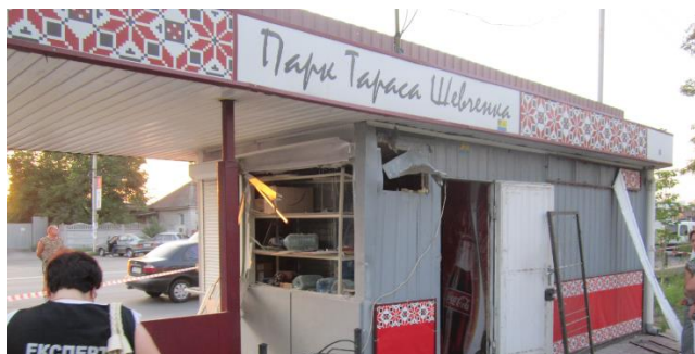
Рисунок 3а – Розривання порошкового вогнегасника, кафе «Парк Тараса Шевченка», м. Бровари (2015 рік)
