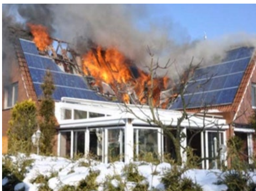
Рисунок 5 – Гасіння пожежі на фотогальванічній системі, змонтованій на житловому будинку, та виникнення контактної пожежі
