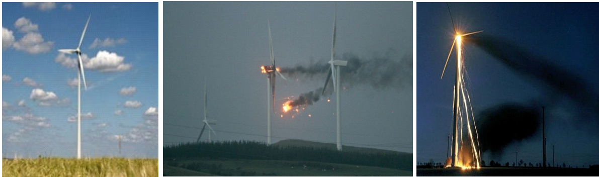
Рисунок 6 – Загальний вигляд вітрової електростанції (а); пожежі внаслідок механічних несправностей (б); пошкодження від пожежі внаслідок удару блискавки (в)
